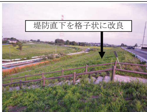
写真① 堤防本体
