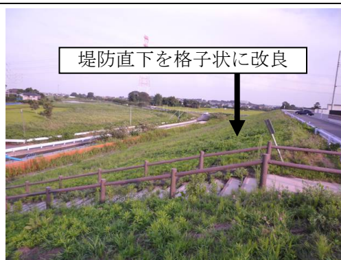
写真① 堤防本体
