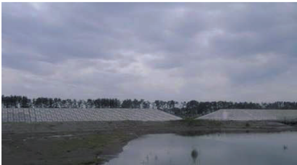
写真 2 完成した堤防の全景
