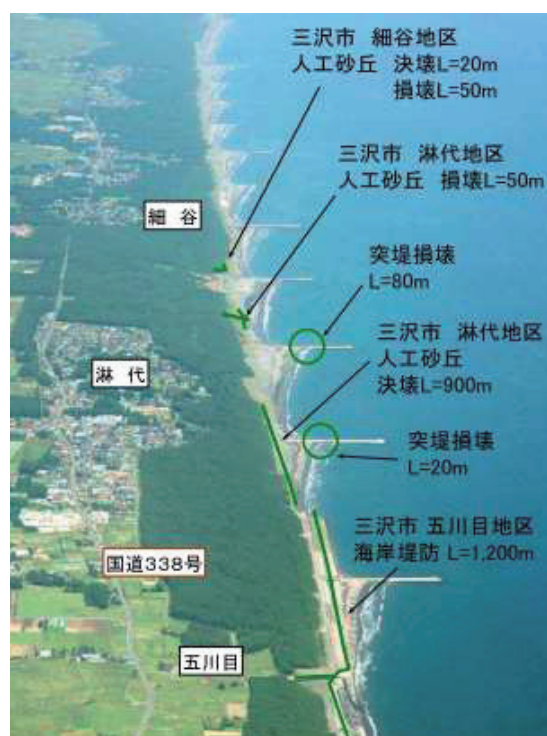
図1 三沢海岸の被害状況 2)
