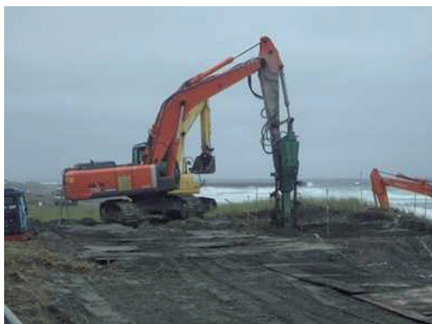
写真 1 施工状況（地盤改良の状況）
