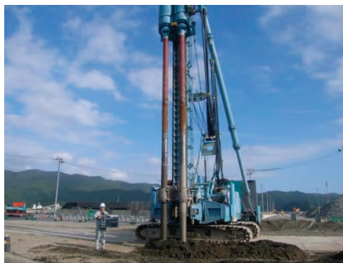
写真 3.5.2 地盤改良の状況（大船渡港海岸） 4)
