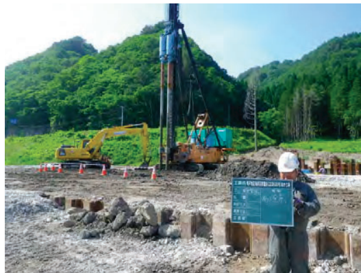
写真 3.5.3 地盤改良の状況（明戸海岸） 4)
