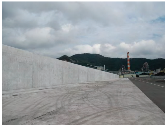
写真 3.5. 既設防潮堤の嵩上げ状況（大船渡港海岸） 5)
