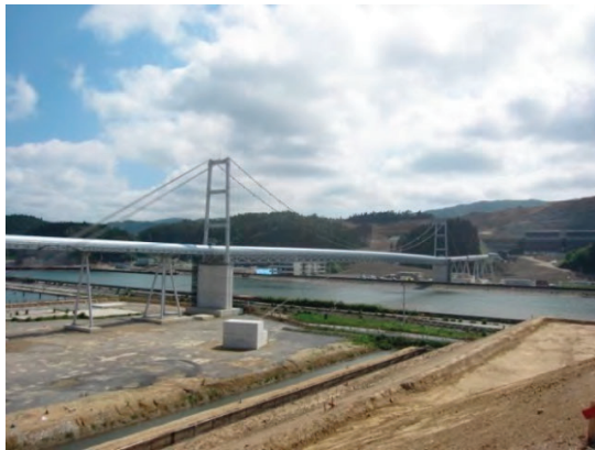
写真 3.2.3 巨大ベルトコンベアの完成状況
