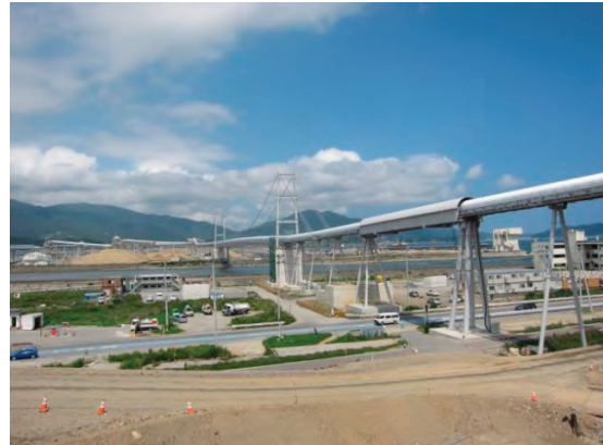
写真 3.2.3 巨大ベルトコンベアの完成状況
