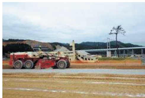
写真3 流用土をセメント改良した盛土工事
