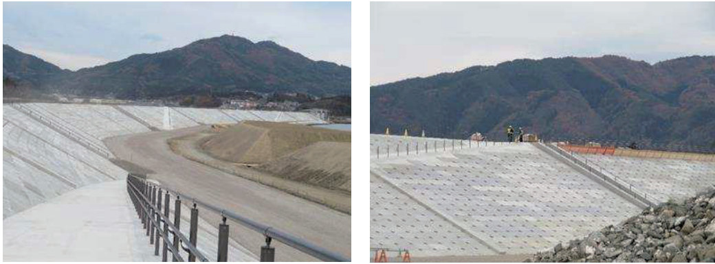
写真 4 第二線堤の施工状況
