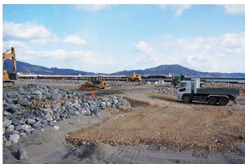
写真2 盛土工事の状況
