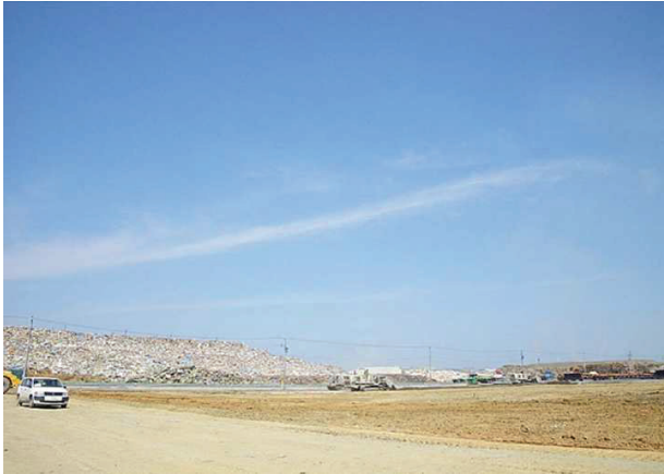
写真 5.1.1 施工状況遠景
