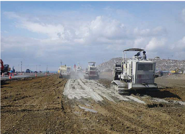
写真 5.1.3 施工状況その2
