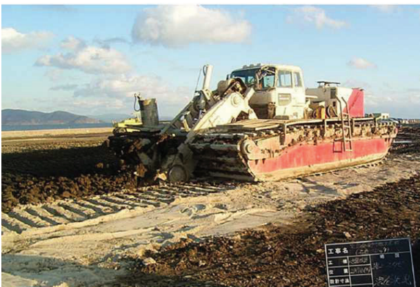
写真 5.1.5 泥上施工機による施工状況その1
