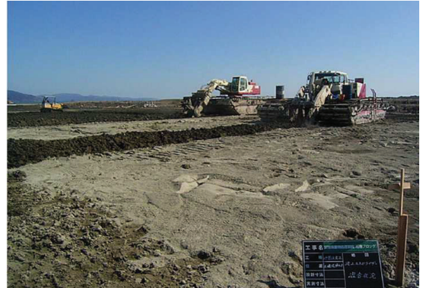
写真 5.1.6 泥上施工機による施工状況その2
