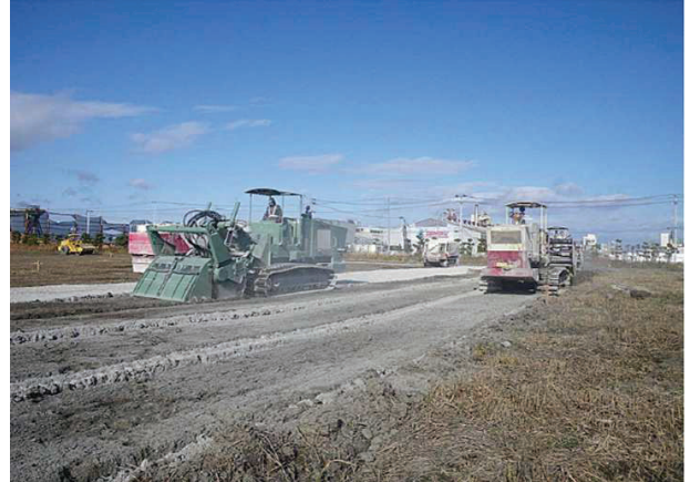
写真 5.1.2 施工状況その1
