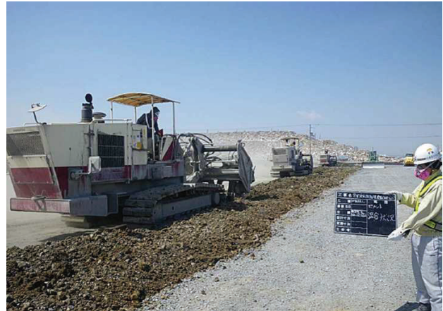
写真 5.1.4 施工状況その3
