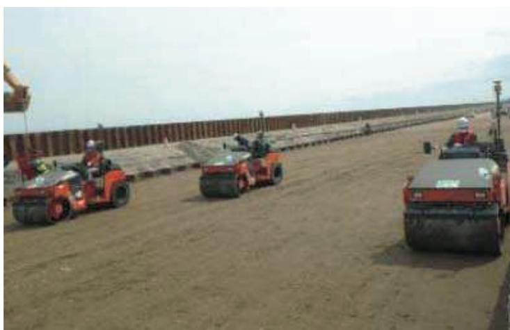
写真4 CSG材の転圧状況
