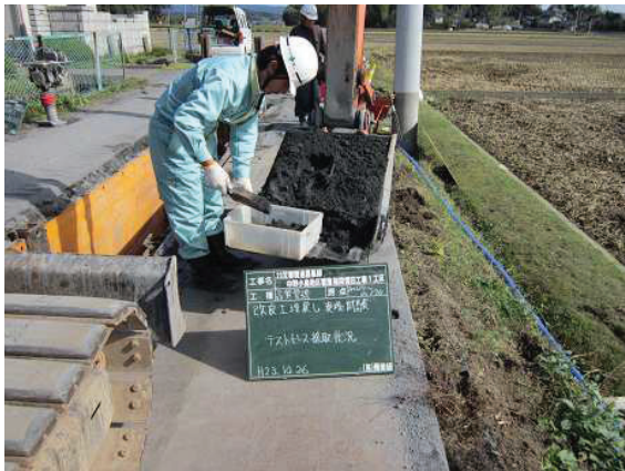
写真 5.2.8 改良土の採取状況
