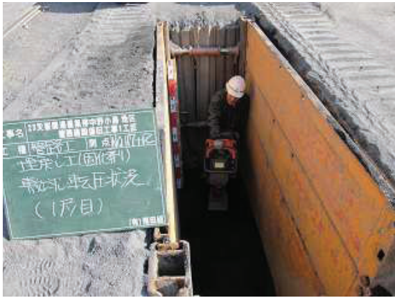
写真 5.2.6 改良土の埋戻し・締固め状況
