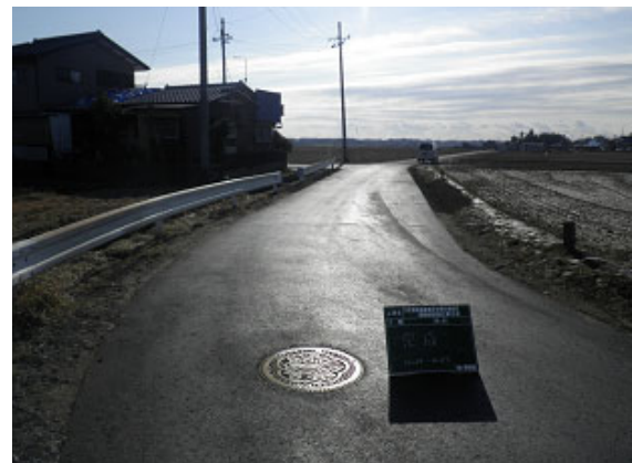
写真 5.2.11 復旧完了状況その 2
