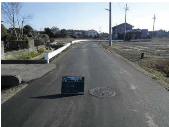
写真 5.2.10 復旧完了状況その 1
