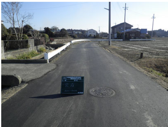
写真 5.2.10 復旧完了状況その 1
