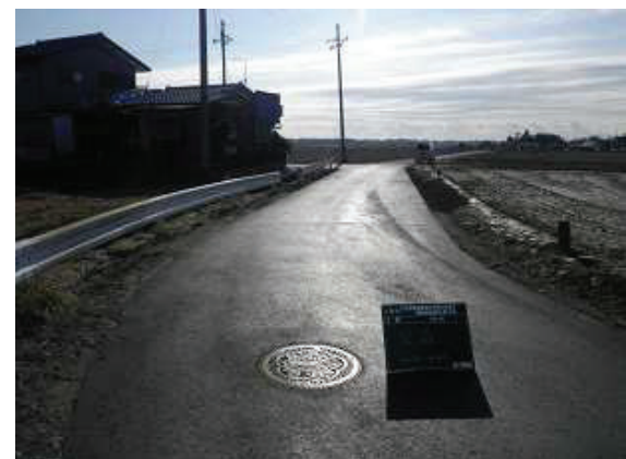
写真 5.2.11 復旧完了状況その 2
