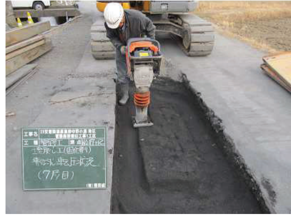
写真 5.2.7 改良土の締固め状況
