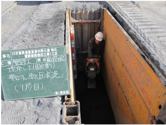
写真 5.2.6 改良土の埋戻し・締固め状況
