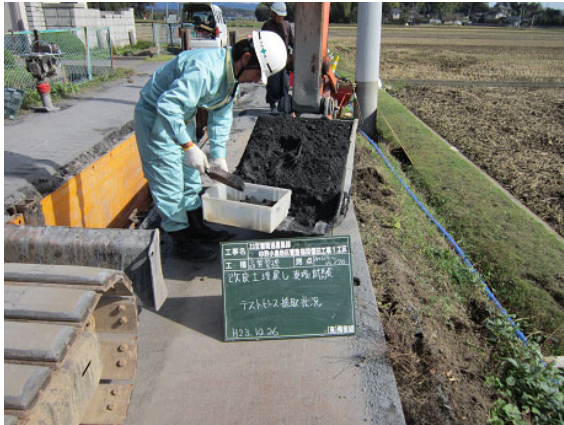
写真 5.2.8 改良土の採取状況
