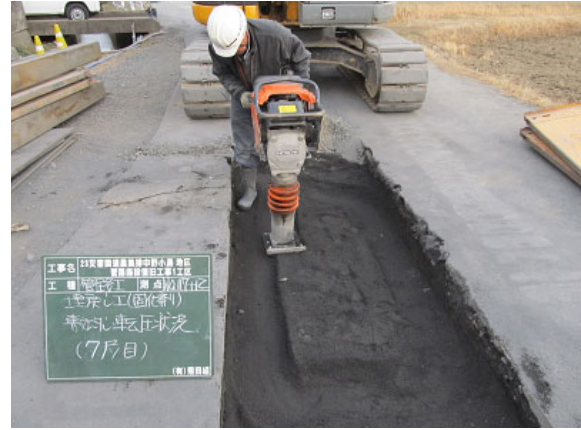
写真 5.2.7 改良土の締固め状況
