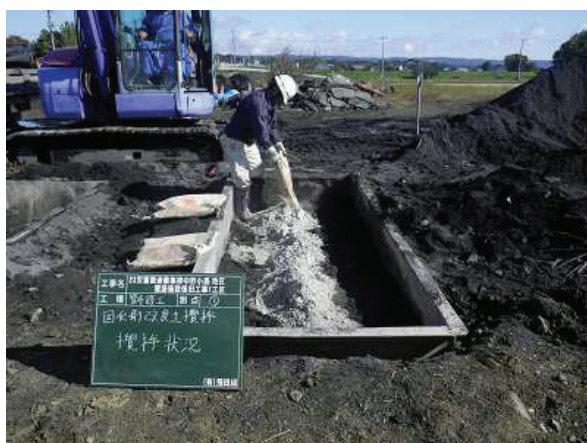
写真 5.2.4 固化材散布状況
