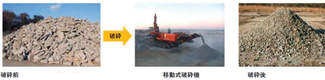
写真 3.7.1 震災コンクリートガレキの破碎状況<sup>4)</sup>
