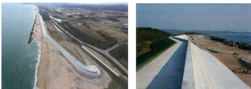
写真 3.7.3 CSG 海岸堤防完成状況<sup>3)</sup>
