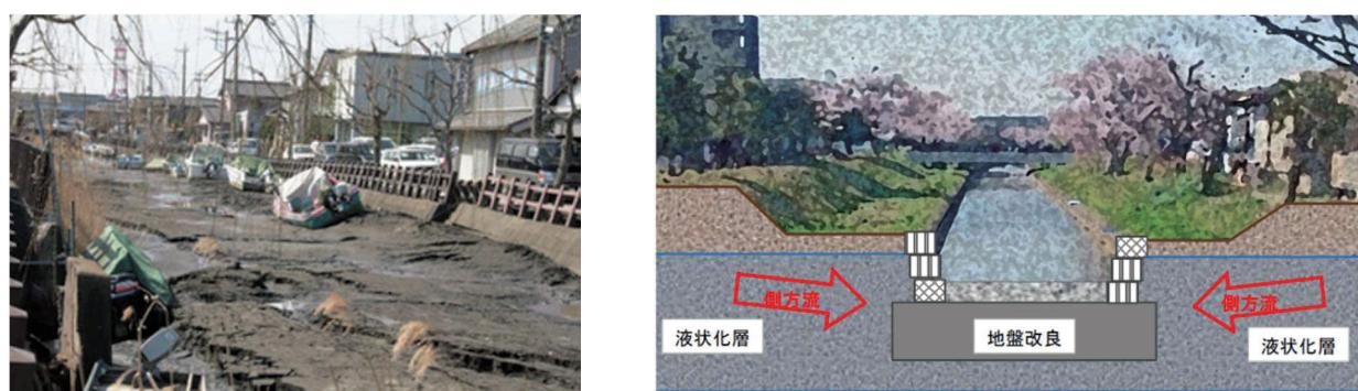
写真1 小野川の噴砂と側方流動
