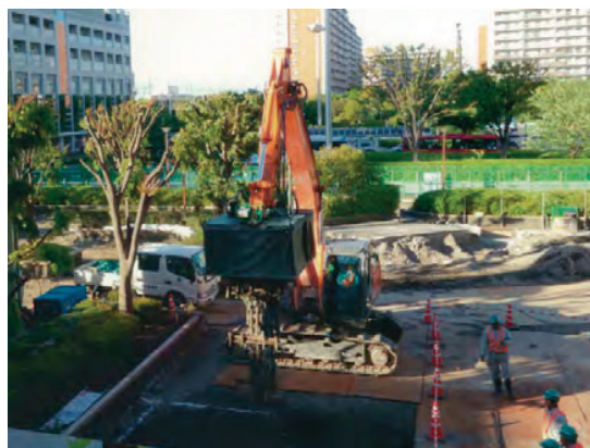
写真 3.3.3 浅層混合処理の状況
