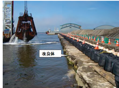
写真 4.6.1 旧岸壁の取り壊し・掘削状況 1)
