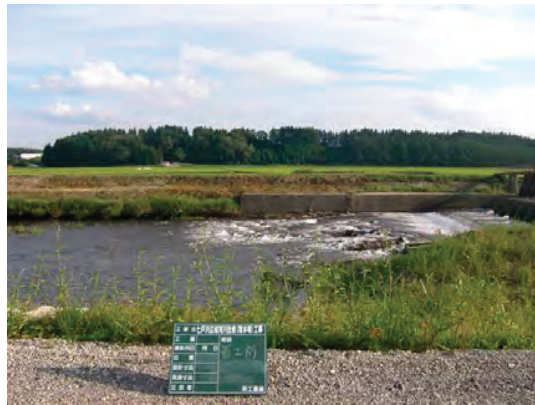
写真 4.5.1 工事着工前の状況
