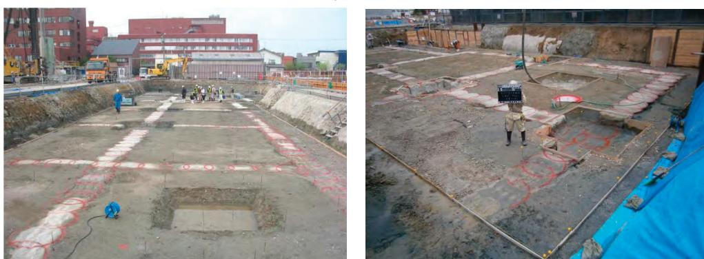
写真 4.12. 地盤改良体の天端の状況
