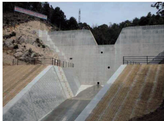
写真4 294 溪流 (コンクリート) 4)
