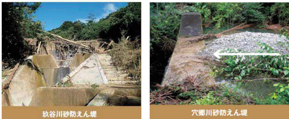
写真 2 砂防えん堤による土石流の捕捉状況 1)
