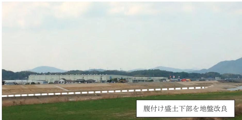
写真 4.2.2 河川改修の状況
