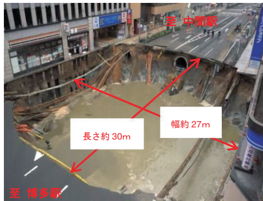
写真 1 陥没の状況 1)
