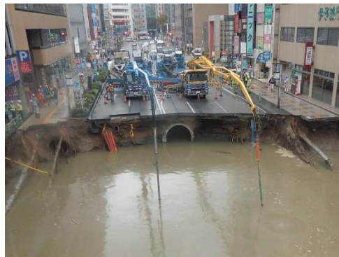
写真2 埋戻し状況 1),2)
