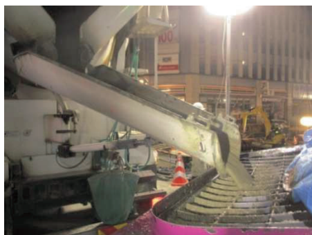
写真 5 流動化処理土の充填状況 2)
