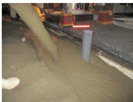
写真 5 流動化処理土の充填状況 2)
