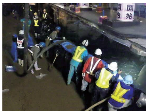
写真3 基礎周辺の充填 1),2)
