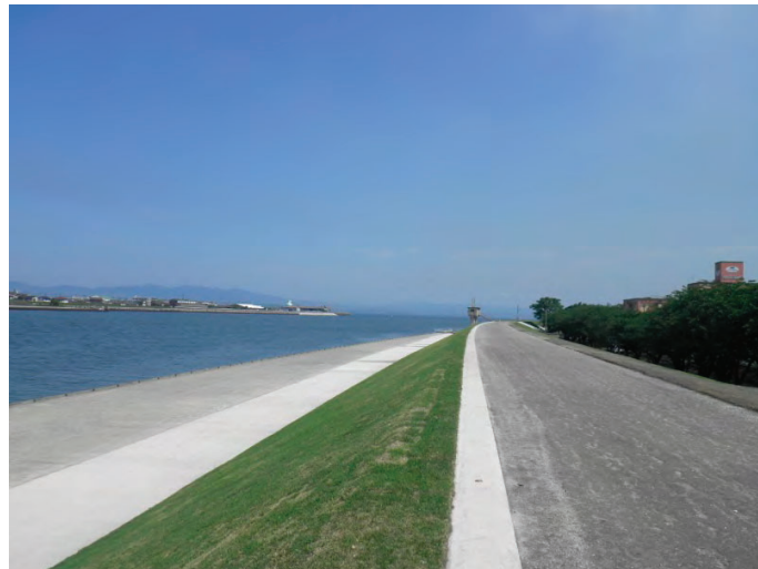
写真 4.1. 工事完成状況
