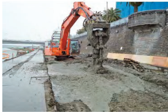
写真 4.4.1 地盤改良施工状況
