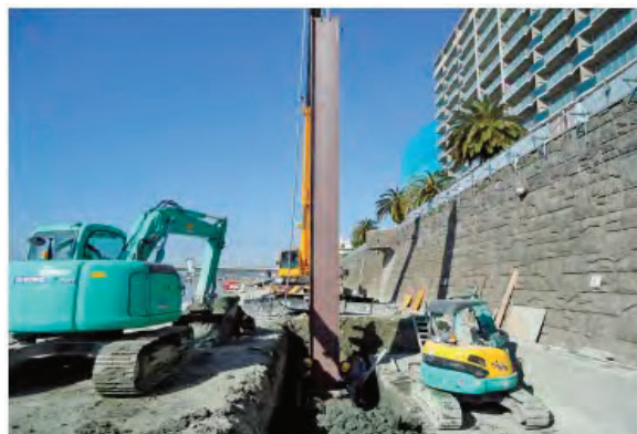
写真 4.4.2 基礎杭工施工状況
