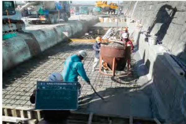
写真 4.4. フーチングコンクリート施工状況
