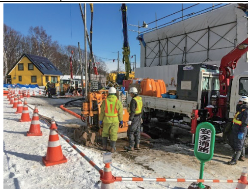
写真2 施工状況（道路部での深層混合処理工法） 3)
