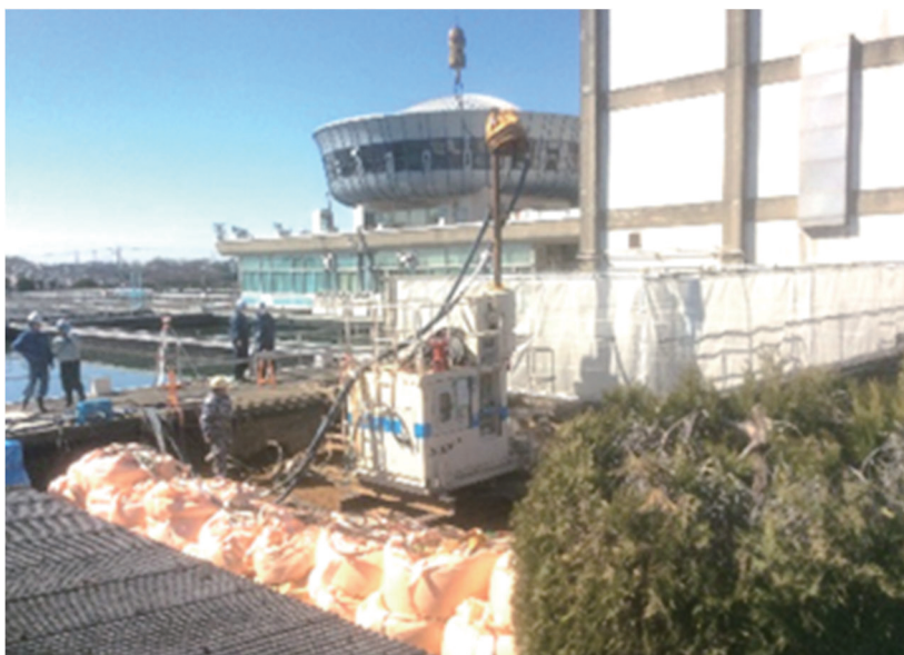
写真 1 高圧噴射攪拌工法の施工状況
