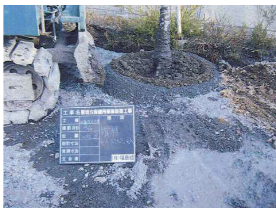
写真 1 地盤改良の状況
