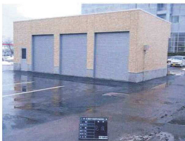
写真 2 完成した車庫
