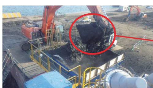
写真6 解碎選別機による泥土投入状況
