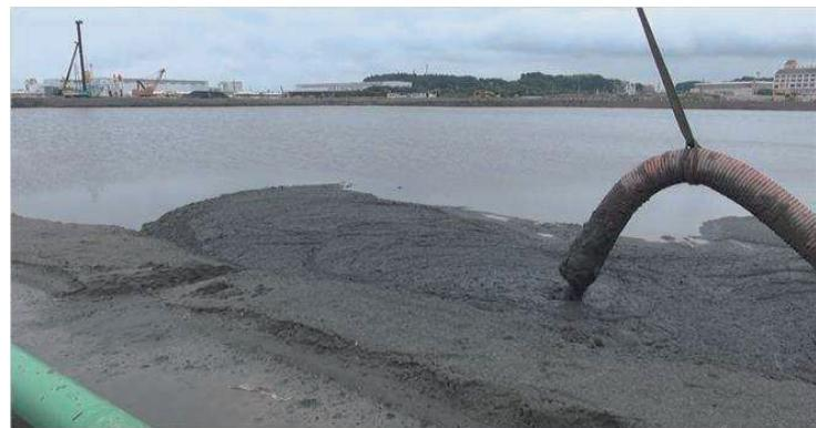
写真3 埋立材利用時の改良土圧送状況
