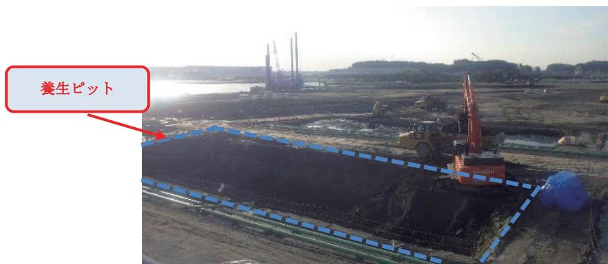
写真5 養生ピットからの場内運搬状況
