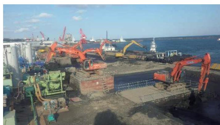
写真4 連続式泥土処理機による施工状況
