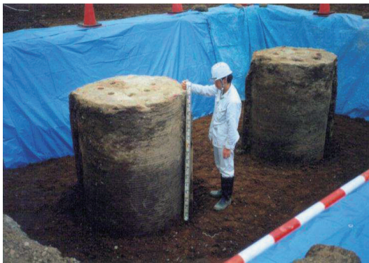
写真1 柱状改良体の全景
