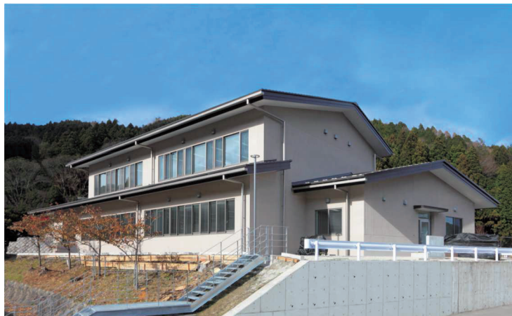
写真 3 事務棟の全景
