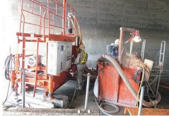
写真2 施工状況（高圧噴射工）
