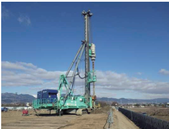
写真1 深層混合処理工の状況
