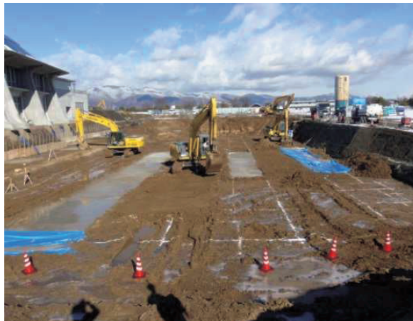
写真2 浅層混合処理工の状況
