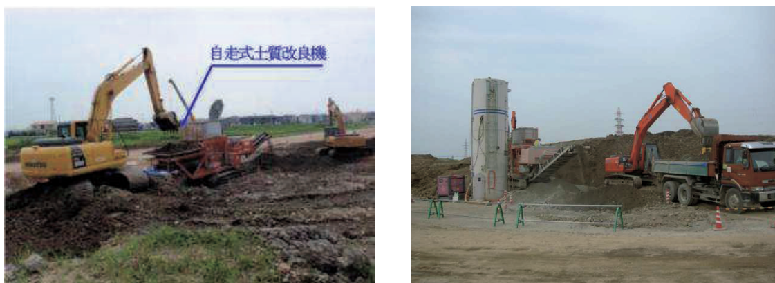
写真 1 土質改良の状況
