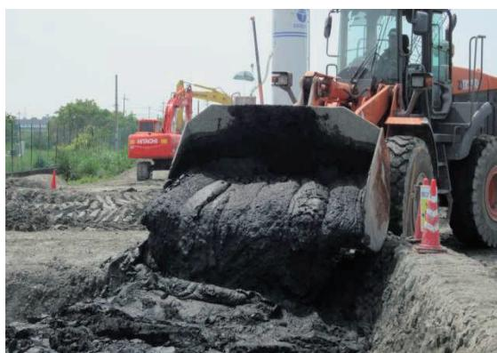
写真7 固化材を練混ぜ直後の改良土
