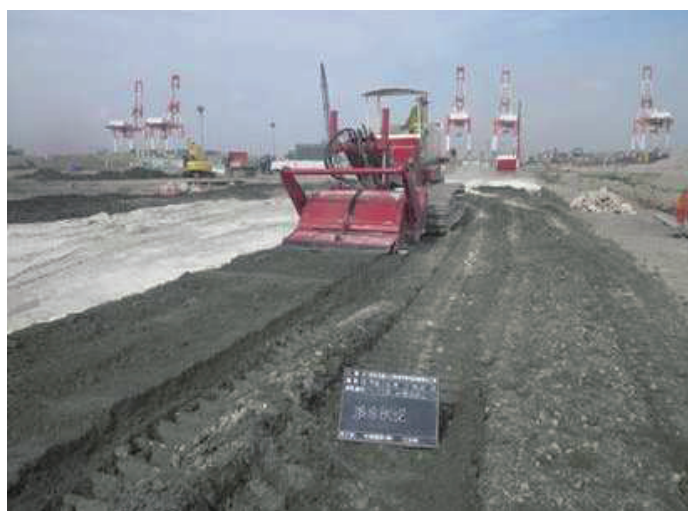
写真1 地盤改良の状況
