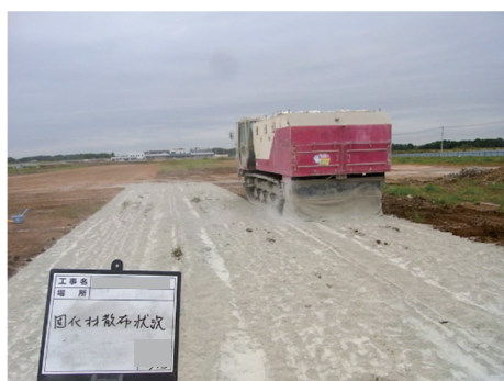
(a) 散布車による固化材散布
