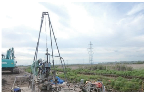
写真 6 コアボーリングの状況
