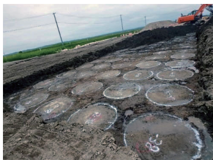
写真4 改良体の状況1
