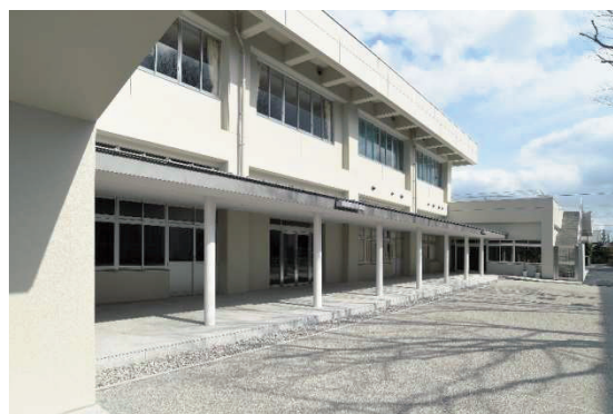
写真2 改築工事の完了の状況
