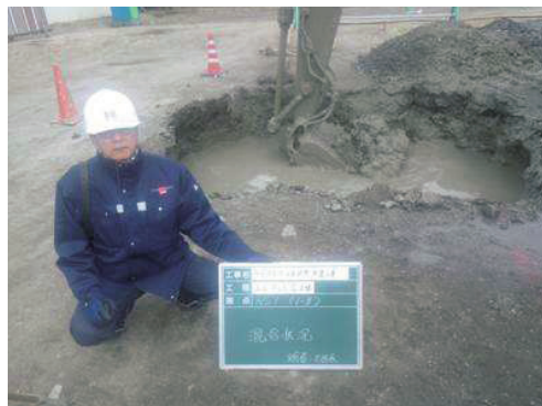
写真1 地盤改良の状況
