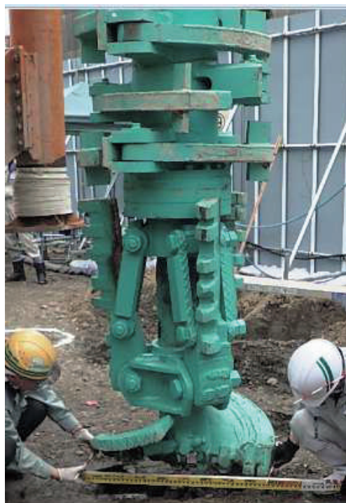
写真 1 攪拌翼の縮小径 (空掘部)
