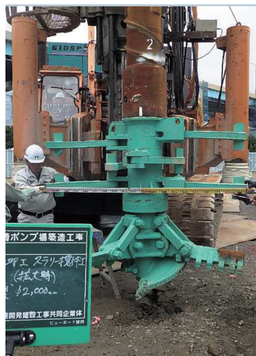
写真 2 攪拌翼の拡大径 (改良部)
