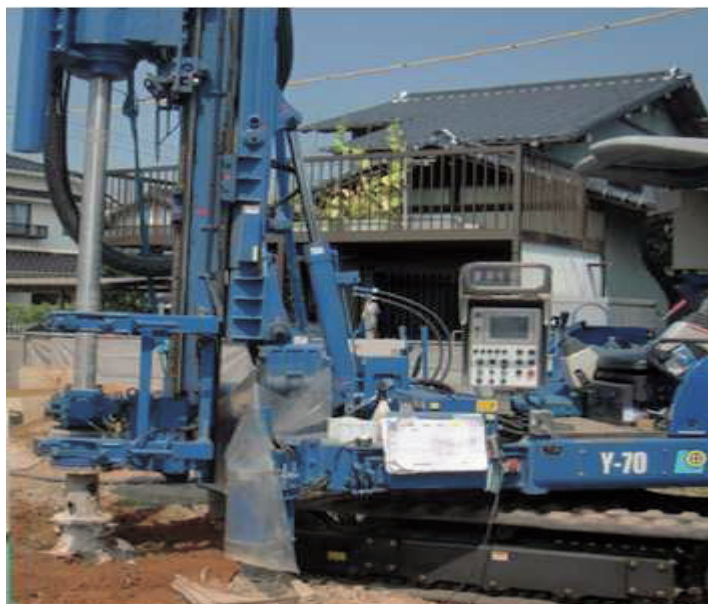
写真2 地盤改良施工状況
