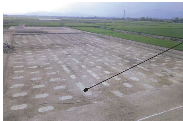
写真 1 改良体の造成状況
