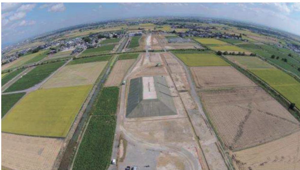
写真 2 試験盛土の完成状況
