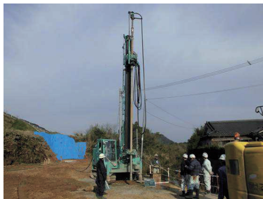
写真2 地盤改良の状況2
