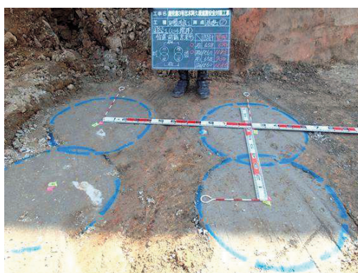
写真3 改良体の出来形
