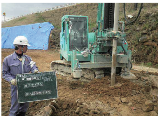
写真1 地盤改良の状況1
