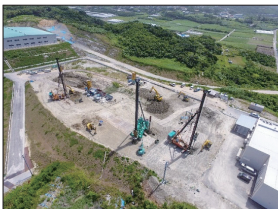
写真 1 施工状況(全景)
