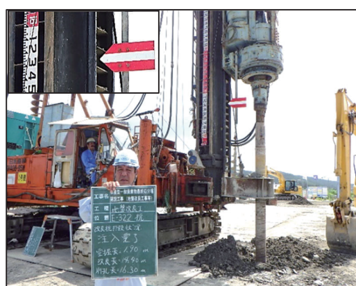
写真 2 施工状況(攪拌状況)
