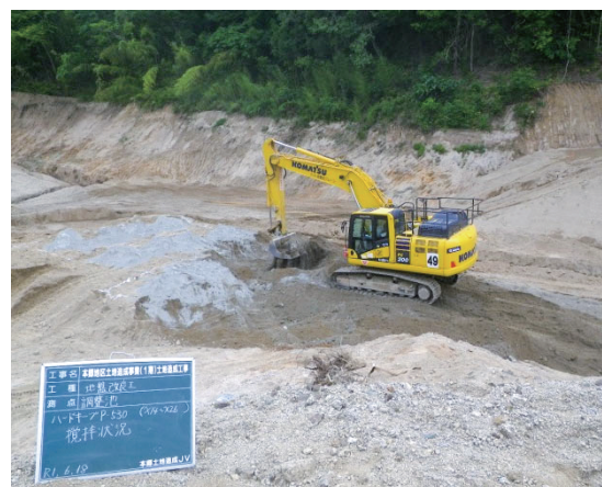
写真2 固化材の混合攪拌状況
