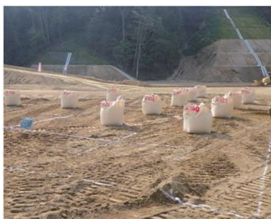
写真 3 固化材散布の区画割り状況
