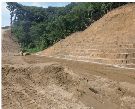
写真5 改良盛土の構築状況
