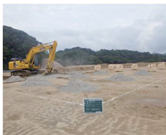
写真 4 固化材の混合攪拌状況
