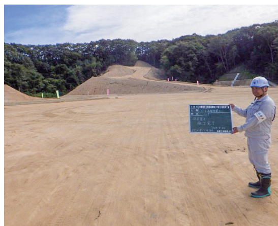
写真6 改良盛土の施工完了状況
