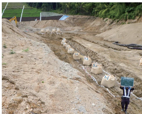
写真1 固化材散布の区画割り
