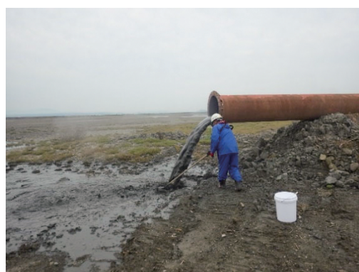
写真 3 固化処理土の採取状況
