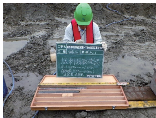
写真 7 コア供試体の状況
