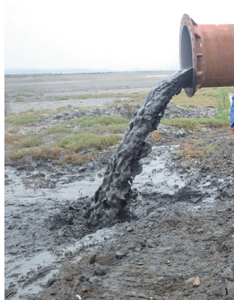
写真 1 固化処理土の圧送状況
