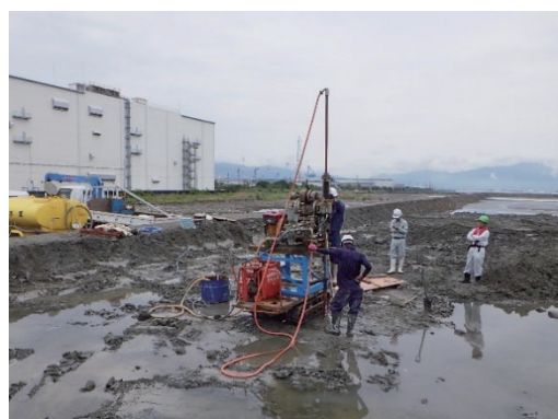
写真 6 施工後の試料採取状況
