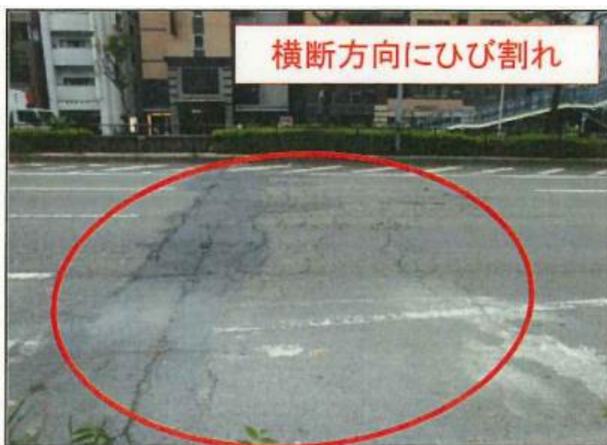
コンクリート工事前のアスファルト舗装の様子
