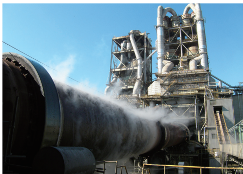
奥から手前に延びる巨大な回転窯が目を引く埼玉県のセメント工場（太平洋セメント熊谷工場）。[写真提供]太平洋セメント
