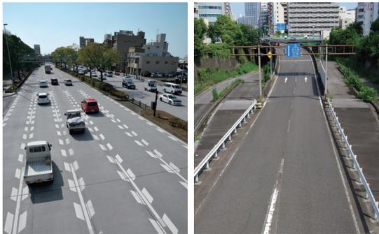
左写真のコンクリート舗装の路面は、右のアスファルト舗装と比べて白く、夏場では表面温度が10℃程度低くなる調査結果があり、ヒートアイランド抑制効果が期待できる。
