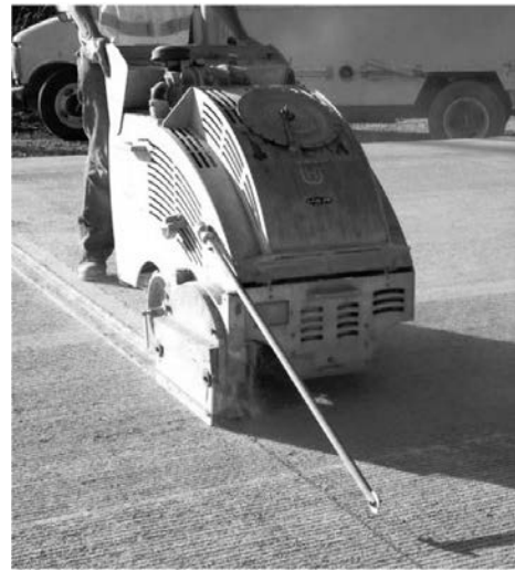
写真2 乾式の早期切断型カッター
