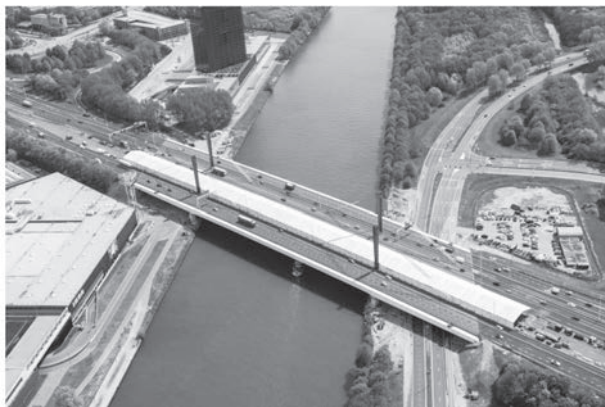
写真1 橋梁上の白いテントが施工用全天候型テント
