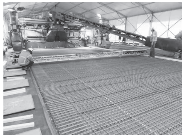
写真2 スリップフォームペーバと手前の鉄筋位置迅速測定装置
