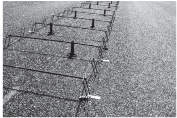
プライマシール施工後
